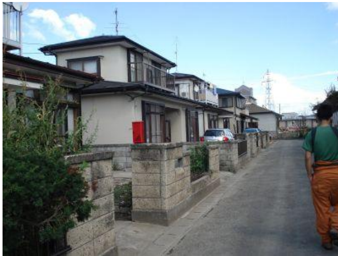
外観からは無事そうですが・・・ 津波により1階が浸水
