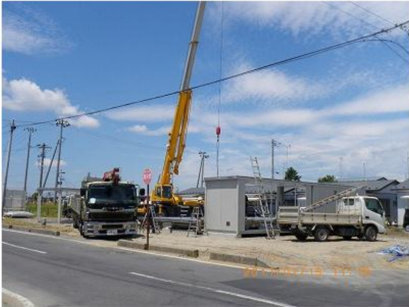
青空に伸びるクレーン。診療所の組み立て開始です。
